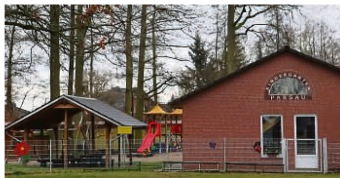
An Parsaus Kindertagesstätte soll angebaut werden. Besonders die Küche ist zu klein. Die Gemeinde will das Vorhaben mit 360 000 Euro tragen.
